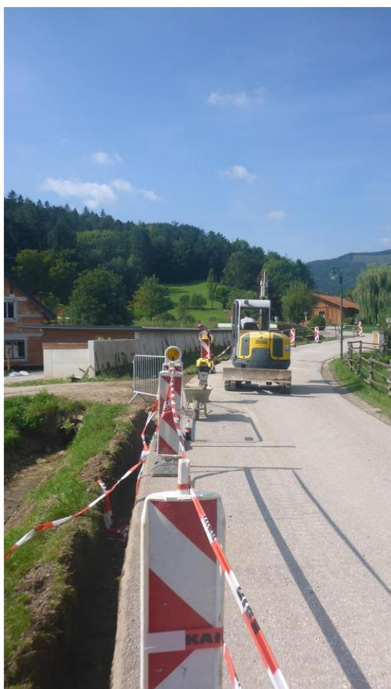
Firma Kaim im Auftrag der Telekom / A1 bei der Errichtung des Glasfaserkabels von Grünbach zum Sender.
